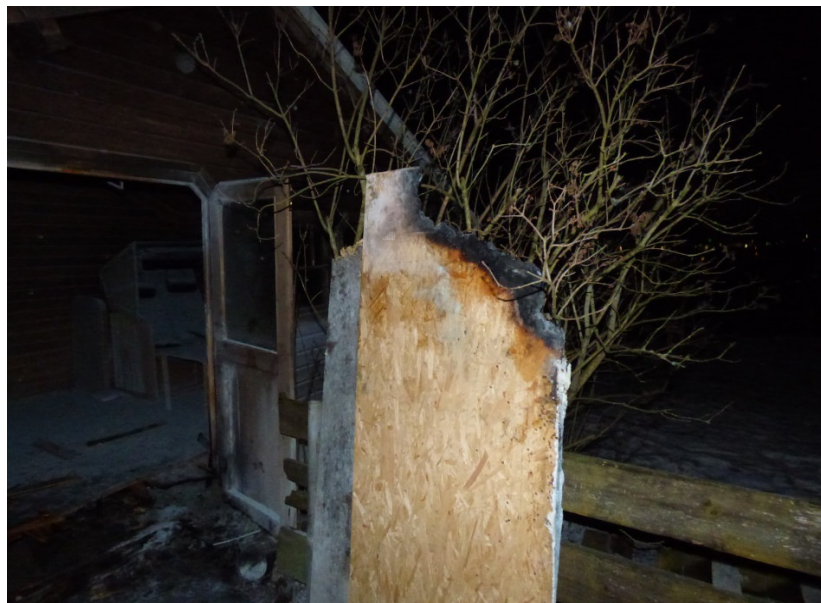
Einsatz Nr. 36 - 27.12.2020 - Brand in Gartenhütte
